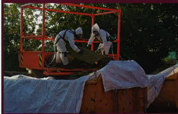
La mise en place de Cuma spécialisées dans le désamiantage permettra de proposer un tarif stable et plus faible. © Matoux - stockadobe.com
