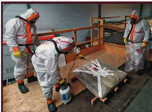
Mise en situation lors d'une formation SS4 au centre NCS à Saint-Herblain : elle est obligatoire pour réaliser des petites interventions de rénovation ou de maintenance autour de matériaux contenant de l'amiante. © Elinnov
