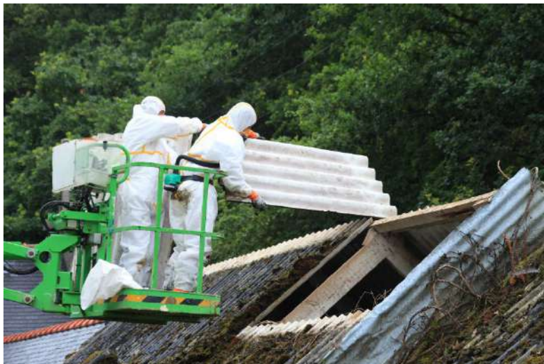
Démontage d'une toiture en fibrociment contenant de l'amiante
