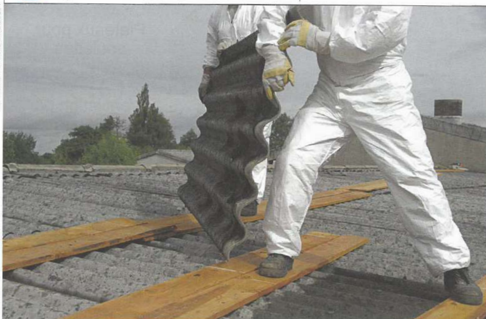
Confier le désamiantage de son bâtiment à une entreprise habilitée coûte entre 40-50 €/m 2 pour une intervention basique jusqu'à 100 €/m 2 .
