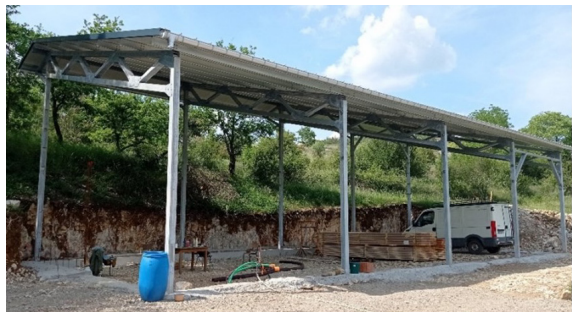
Figure 2 : bâtiment en cours de réalisation mai 2022
