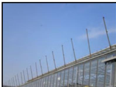
Ce type de garde-corps (incomplet sur la photo) est destiné à recevoir un filet de protection répondant ainsi à la norme NF P93-355.
