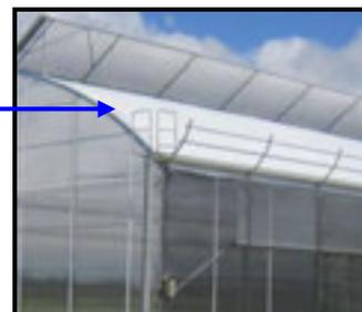
Cette structure fixe dépasse d'1m les chéneaux des serres à couverture souple, permettant ainsi de recevoir en sécurité une échelle mobile (avec crochets selon description page suivante).
