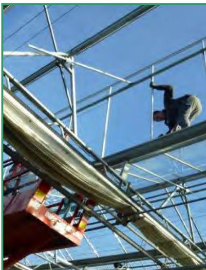
2. Depuis l'intérieur de la serre, élévation des vitres avec la PEMP (Plate-forme Elévatrice Mobile de Personnes).
