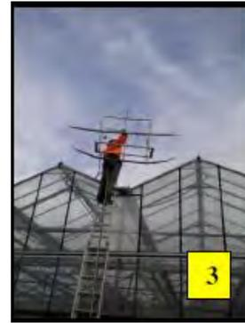
Le chéneau de cette serre est à 5m. L'opérateur porte à l'épaule le déambulateur plié (limitant son encombrement) mais ne pouvant pas dans ces conditions appliquer la règle des 3 points d'appuis. Arrivé en haut de l'échelle l'opérateur doit faire passer le déambulateur par-dessus l'élément d'échelle dépassant d'1m le chéneau.
