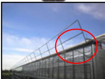
Sans analyse technique approfondie, nous observons que les poteaux de ce garde-corps sont fixés sur le chéneau et non sur la structure de la serre. S'il peut rassurer un opérateur se déplaçant dans le chéneau il ne pourra pas retenir un opérateur en glissade sur la surface en pente de la serre (conformément à la classe B de la norme NF EN 13374)
