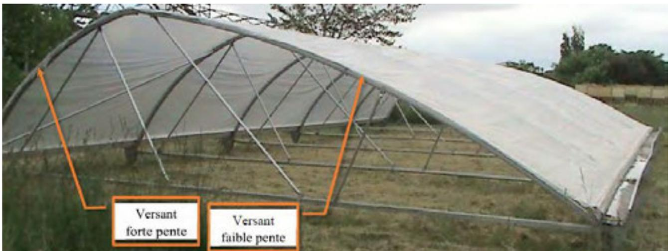
Structure utilisée pour les essais
