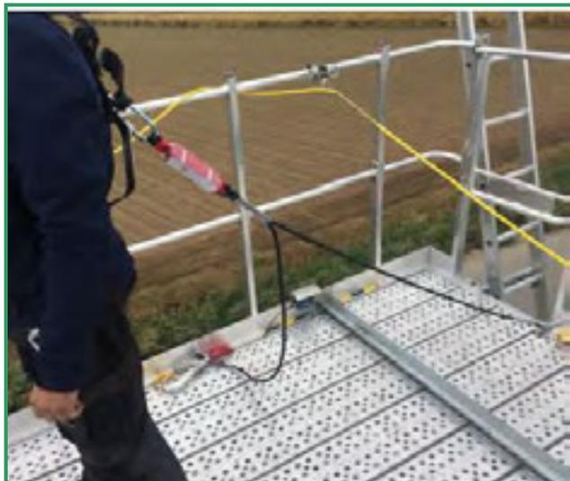
L'intervenant sur la plate-forme est équipé de moyens anti-chute (Art R.4323-61) afin de compenser l'impossibilité technique de disposer de garde-corps sur toute la périphérie. Seuls les points d'ancrage installés et qualifiés par le constructeur et l'employeur sont dans ce cas utilisables (Art R.4323-61).
