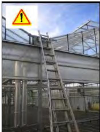
« Les échelles d'accès doivent dépasser d'au moins un mètre le niveau d'accès, à moins que d'autres mesures soient prises pour garantir une prise sûre. »
