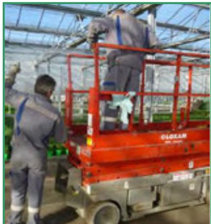
1. Utilisation d'une PEMP pour ces travaux sur serres. Chargement des vitres dans la plate-forme de la PEMP.
