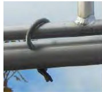
Bridage du déambulateur sur le garde-corps de l'échafaudage roulant
