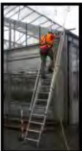
Echelle à marches avec crochets stabilisateurs et rampes.
