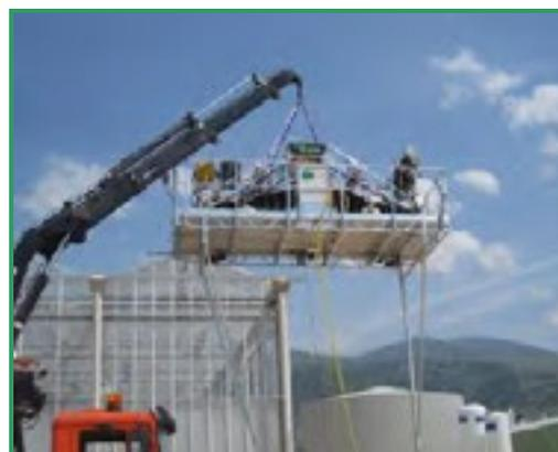
Elévation et mise en place de la plate-forme avec le nettoyeur de toit sur la structure support en façade de la serre.
