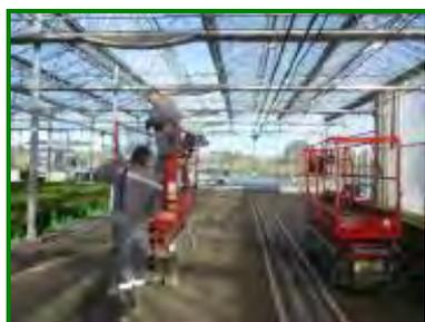
Cette PEMP de **catégorie 3A** est utilisée dans cet exemple pour le changement de vitres sur une serre verre. Elle permet de l'intérieur l'élévation de vitres et du personnel à proximité de la zone de travail dans la limite de la portée max. indiquée sur la notice d'instructions.
