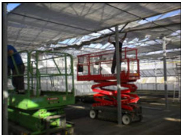
Entretien des toiles d'ombrage, des écrans thermiques, de l'irrigation...
