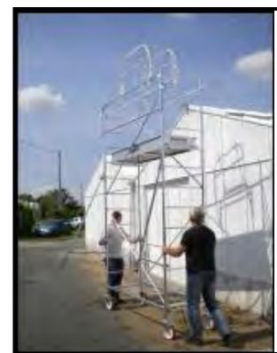
6. Déplacement au chéneau suivant de l'ensemble (Echafaudage et déambulateur).
