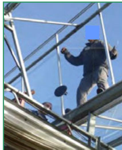
3. A deux, début de la manutention de la vitre, de la PEMP au châssis de toiture.
