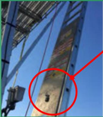
L'échelle **sans crinoline** est équipée en partie basse d'une plaque de tôle cadénassée limitant ainsi l'accès à la plate-forme aux seules personnes qualifiées.
