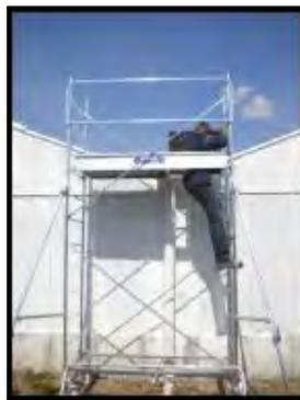
2. Accès de l'opérateur sur le plateau de travail par la trappe du plancher..
