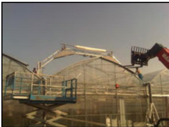
Le rouleau de bâche est installé sur le portique au sol et l'ensemble élevé sur la chapelle avec un équipement de levage adapté.
