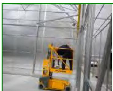
Ces PEMP de **catégorie 3A**, de tailles différentes sont utilisées en interne pour des travaux de maintenance. Leur utilisation nécessite planification des travaux car les espaces au sol doivent être dégagés.
