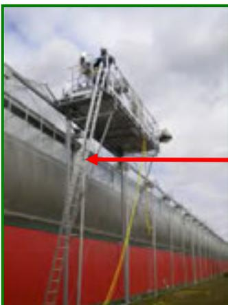
Au-delà de 3m de hauteur les **échelles fixes** doivent être munies de crinolines.
