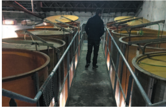
Protection permanente d'une passerelle de visite
