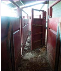
La porte sectionnelle qui permet d'entrer dans le couloir et d'intervenir derrière un animal
