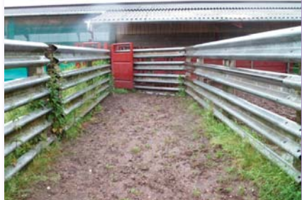
L'amène des animaux pour accès à la porte latérale d'entrée de couloir. Dans cet espace, une demi glissière est positionnée en bas de parois
