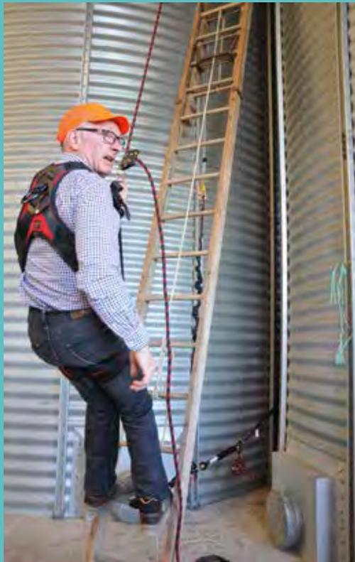
Sécuriser l'ascension d'une échelle entre deux silos, c'est possible et c'est même recommandé, notamment avec un système de coulisseau, de harnais et un point d'ancrage sur une poutre en hauteur. De quoi limiter le risque de chute, qui peut être grave.
