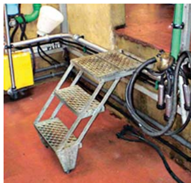
Escaliers avec une profondeur de marches différente.
