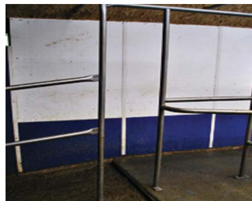
Dimension : 35 cm utiles entre les poteaux
