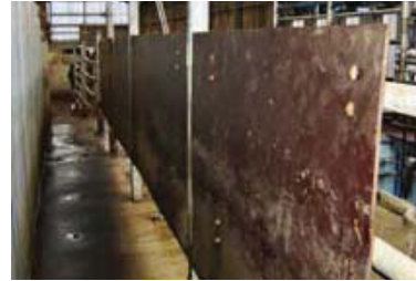
Parois pleines installées sur couloir de retour.
