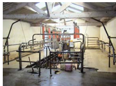
Salle de traite lumineuse avec translucides
