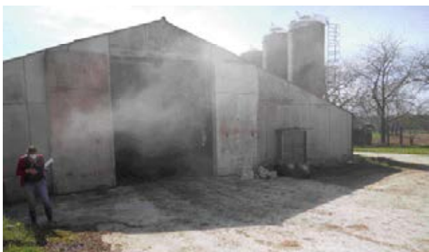
Vue de l'extérieur lors du dépeussierage
