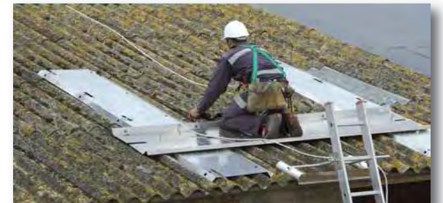
Deux planchers sont posés en parallèle sur le toit. Un troisième plancher est posé perpendiculairement sur les deux autres. L'intervenant dispose d'un chemin en U entourant la zone d'intervention
