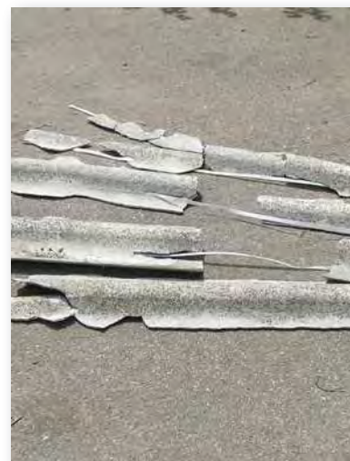
Les feuillards de renfort n'empêchent pas les accidents
