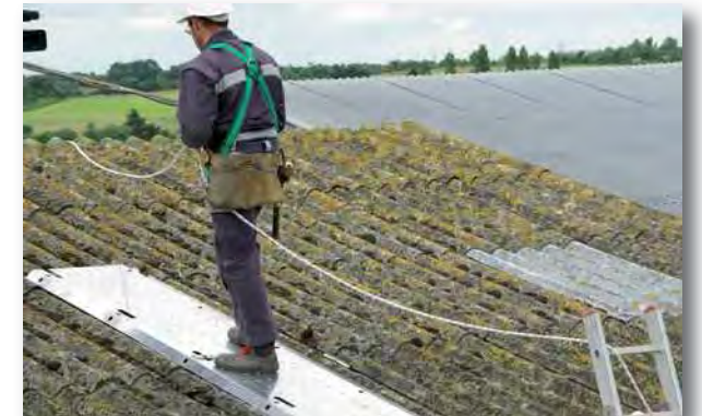
Les planchers permettent d'évoluer sur la toiture. Ils doivent toujours porter au moins sur 2 pannes
