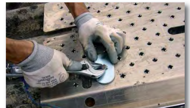
La fixation est réalisée au niveau des tire-fond existants
