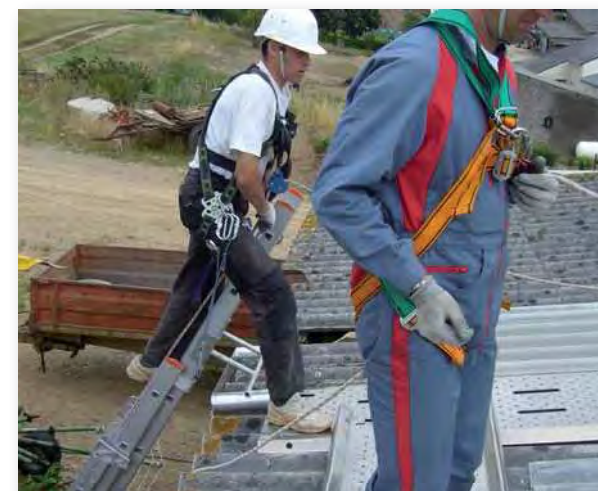
L'échelle doit dépasser la toiture de un mètre, elle est munie d'un stabilisateur
