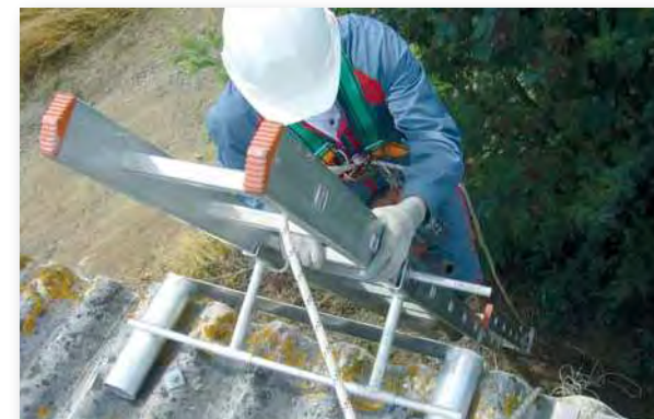
L'échelle doit dépasser la toiture de un mètre, elle est munie d'un stabilisateur
