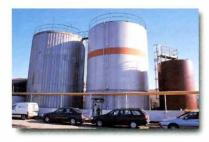
La période d'enrichissement en dioxyde de carbone peut être prolongée avec l'utilisation d'un réservoir de stockage de l'eau chaude : une chaudière fonctionne le jour pour injecter du dioxyde de carbone, la chaleur produite étant stockée pour être utilisée la nuit dans la serre.
