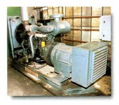
Un moteur thermique, couplé à un générateur, permet la fabrication d'électricité. Il est généralement placé dans un local ventilé extérieur à la serre. Quand cet éloignement n'est pas suffisant, les gaz d'échappement peuvent s'accumuler dans la serre.
