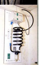
Les capteurs électrochimiques peuvent être aussi bien utilisés en installations fixes qu'en équipements portables. Les capteurs à infrarouge sont toujours installés à poste fixe.
