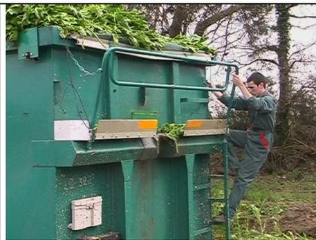
2. Il monte sur l'échelle verticale et bascule le garde-corps
