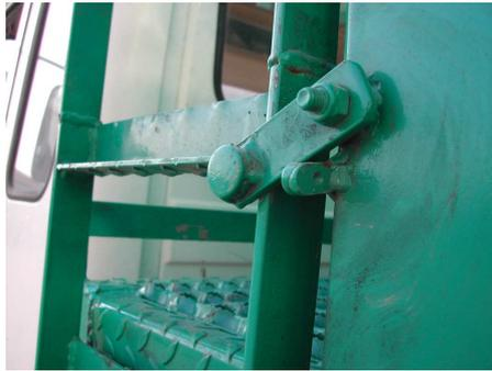
Chaque barreau en fer plat antidérapant a une profondeur d'appui de 3,5 cm. L'écart entre barreau est de 25 cm.
