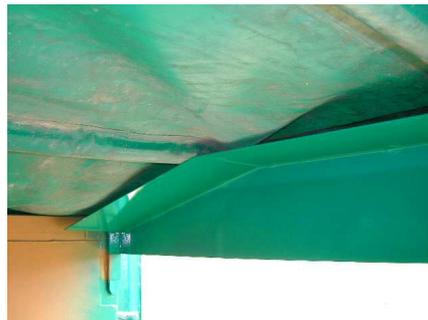
Les trois tubes incorporés à la bâche permettant de la tendre ont été fixés à leur fourreau par deux rivets. Ainsi, ils ne coulisent plus.
